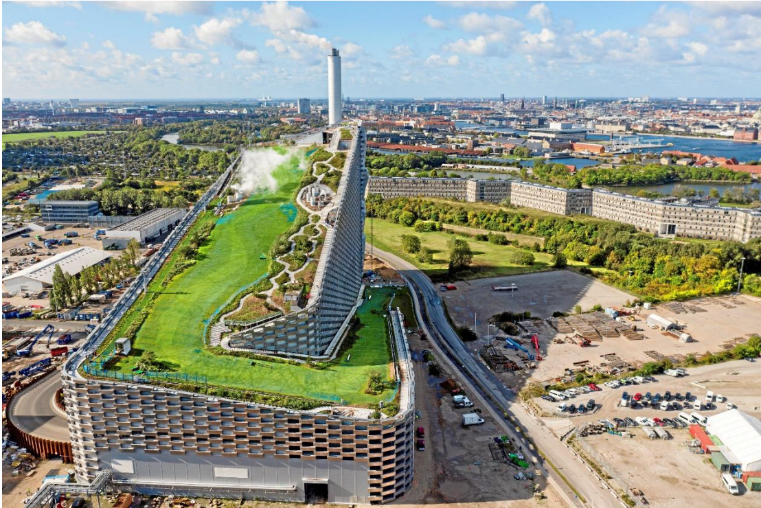
Εικόνα 21 Εργοστάσιο Amager Bakke
