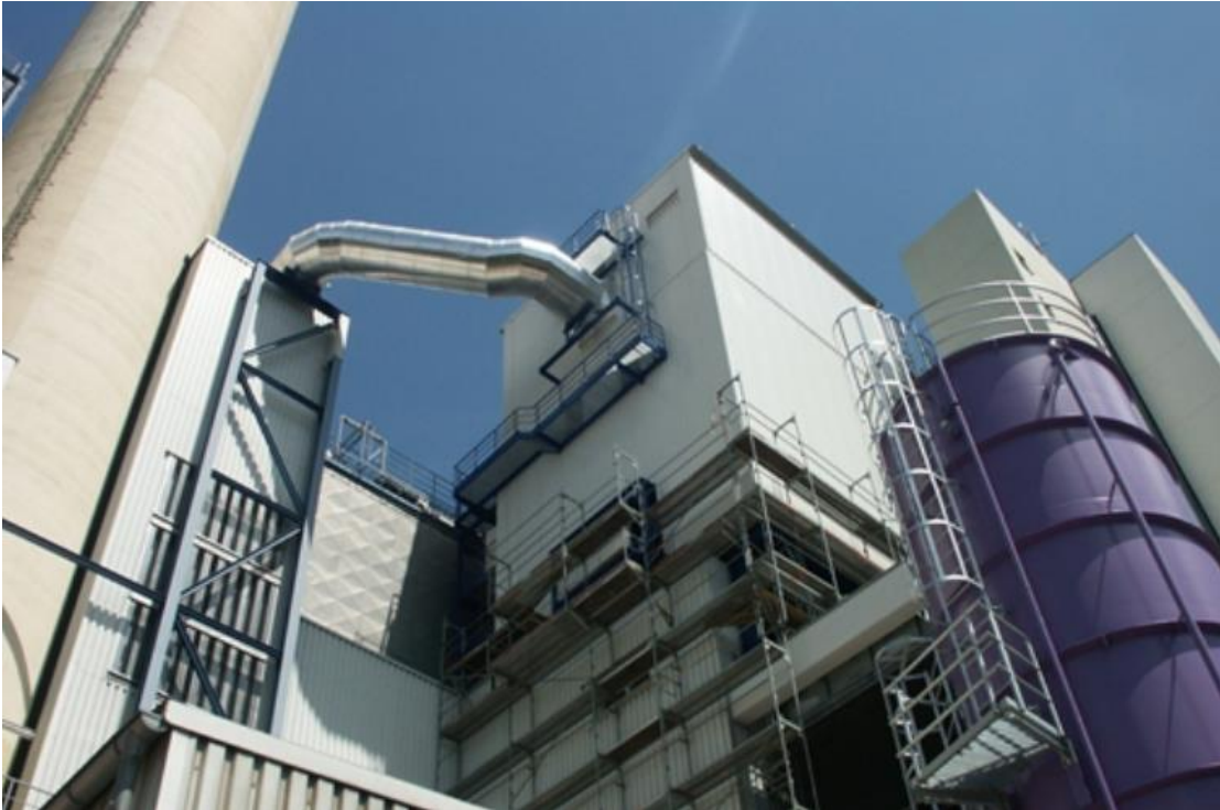
Εικόνα 19 Εργοστάσιο μετατροπής αποβλήτων σε υδρογόνο, Wuppertal Γερμανίας Πηγή: https://www.wtert.net
