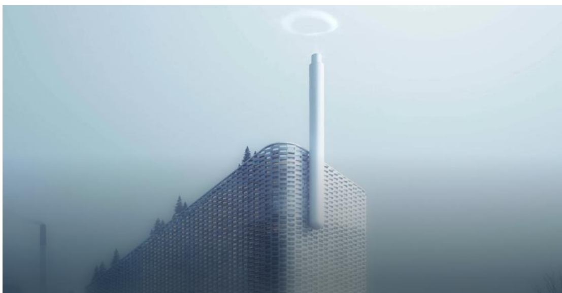
Εικόνα 24 Εργοστάσιο Amager Bakke – Δαχτυλίδι ένδειξης μετατροπής ενέργειας
