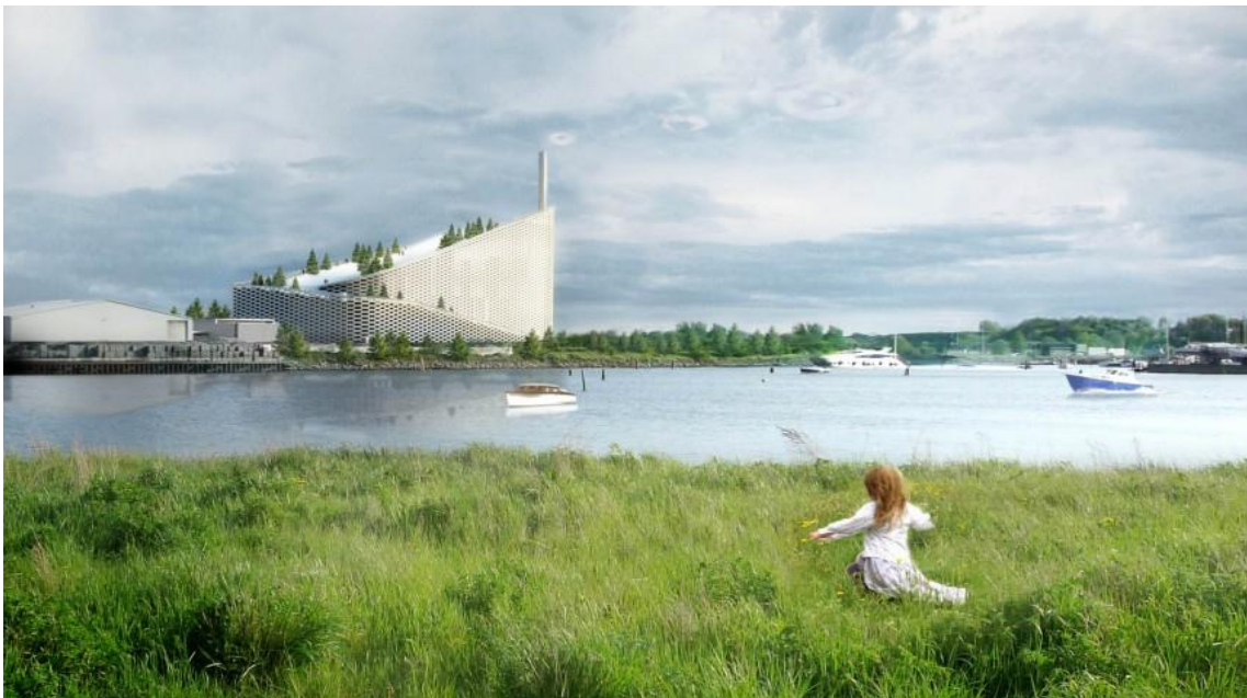
Εικόνα 20 Εργοστάσιο Amager Bakke
