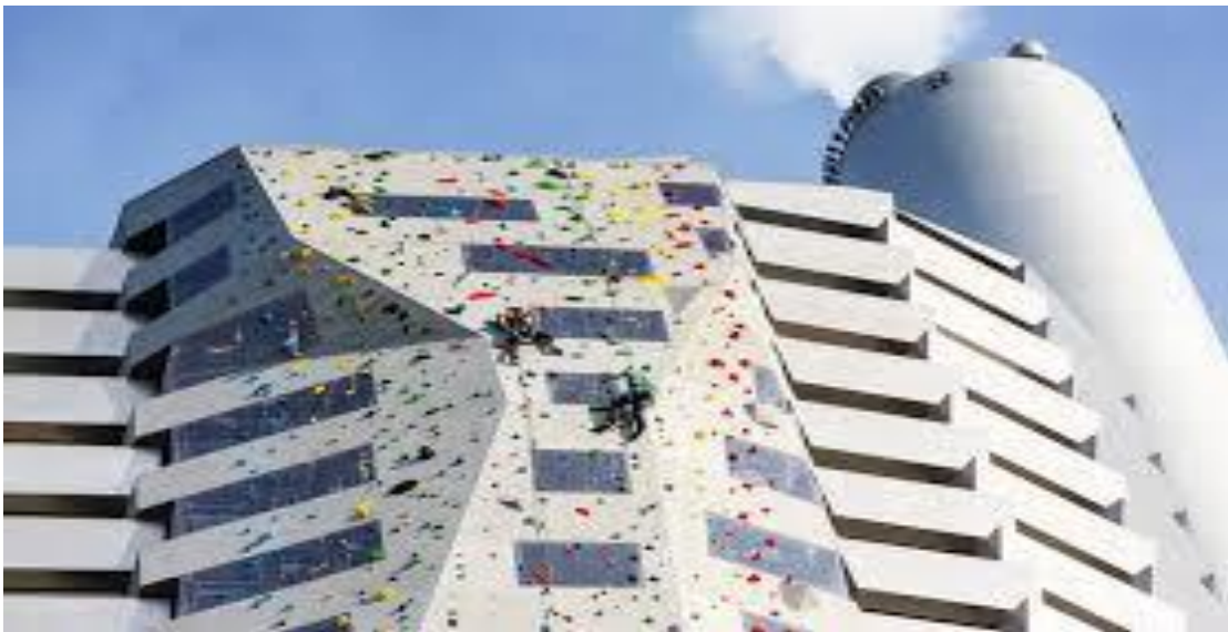
Εικόνα 22 Εργοστάσιο Amager Bakke – Τοίχος αναρρίχησης
